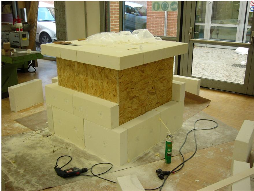
Abbildung 3.2: Bau der Cubes am Beispiel von Cube 6: die tragende Unterkonstruktion aus 2cm starken OSB-Bauplatten wird gedämmt (hier mit 12 cm starken Mineral-schaumplatten) und anschließend mittels UV-beständiger und wasserdichter Unterdachbahn wettergeschützt.
